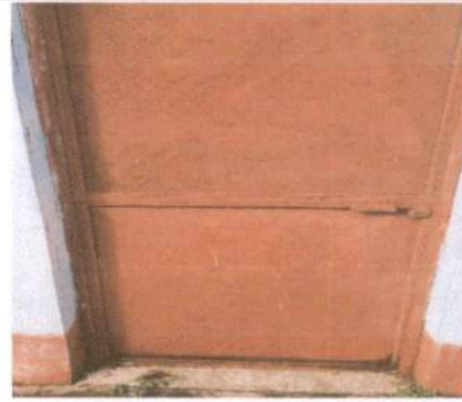
MÓDULO 1 AULAS: PUERTAS DE METAL: Mantenimiento a estructura ( lijado ,cambio de tubo, cepillado, sujeciones, aplicación de pintura), Cambio de chapa.
