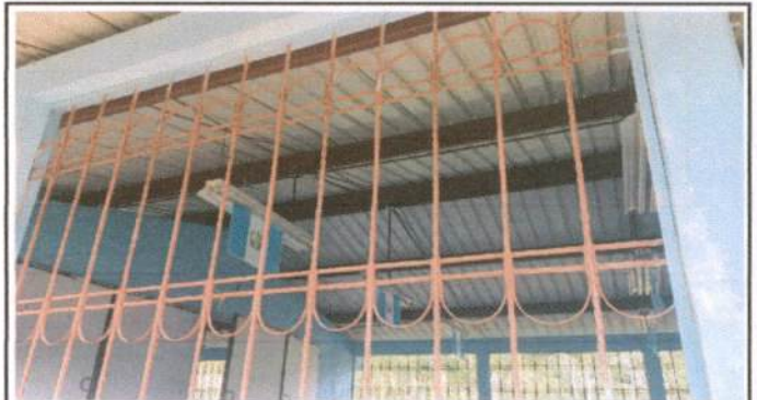
MÓDULO 1 AULAS: VENTANAS: Mantenimiento a balcones de metal.
