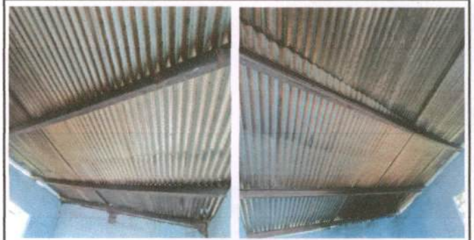
MÓDULO 2 COCINA: CUBIERTA DE LÁMINA: Sustitución de lámina troquelada aluzinc calibre 26, Mantenimiento a estructura de soporte de metal.
